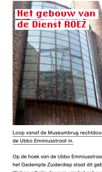
Loop vanaf de Museumbrug rechtdoor de Ubbo Emmiusstraat in.
