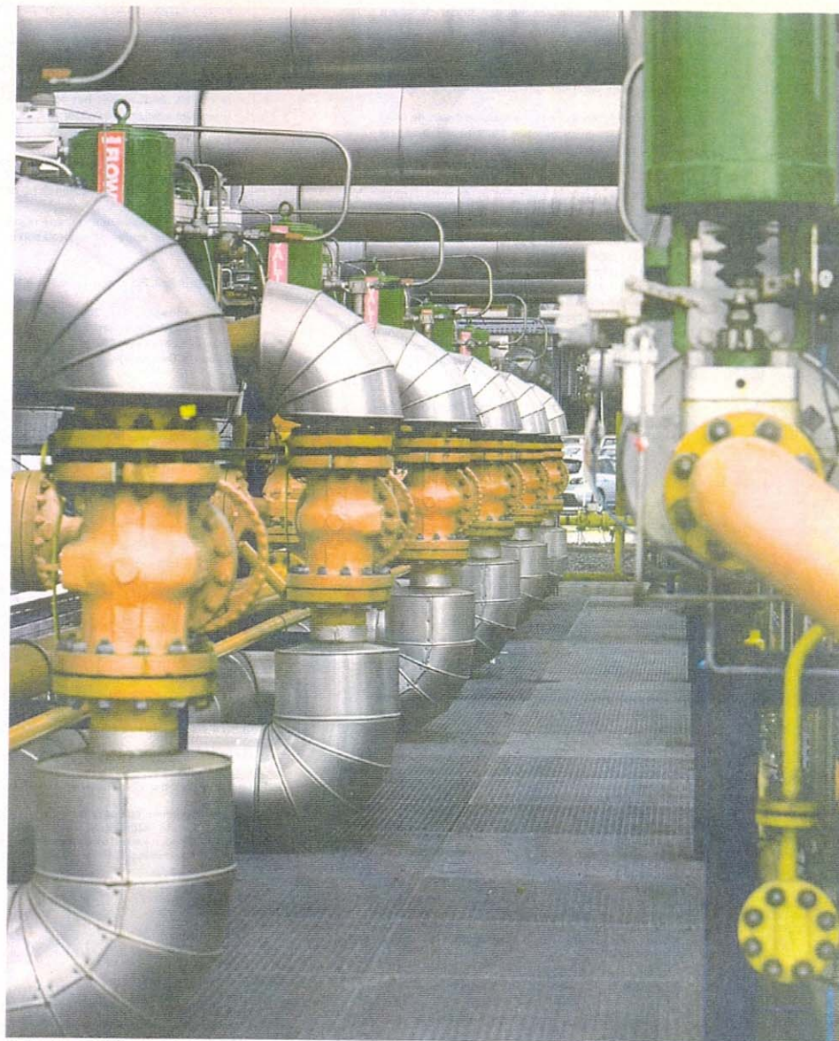
Air Liquide, specialist in industriële gassen, bouwt een waterstoffabriek bij in Rozenburg die de grootste in Europa wordt. Foto Dirk-Jan Visser
